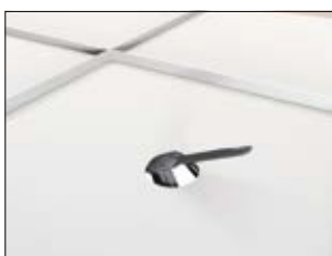
1. breng de afstandhouder in door het montagegat.
