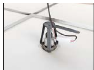
4. sluit de voeding aan en fixeër de aansluitkabel met de kabelclip.
